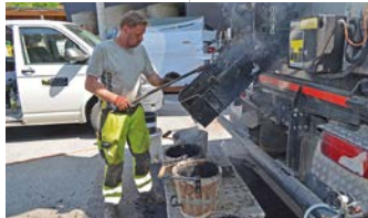
Kurze Bauzeit – Gussasphalt kühlt rasch ab und ist nach wenigen Stunden wieder begehbar
