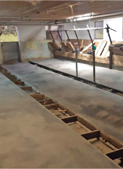
Verlegung von Gussasphalt im Stallbereich
