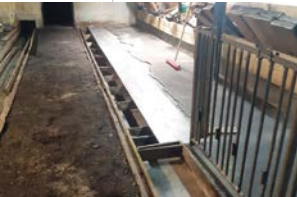
Kurze Bauzeit – Gussasphalt kühlt rasch ab und ist nach wenigen Stunden wieder begehbar
